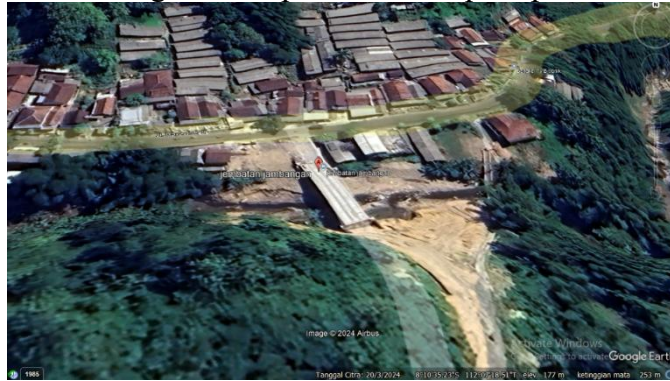
Gambar 1. Lokasi Jembatan Dawuhan
